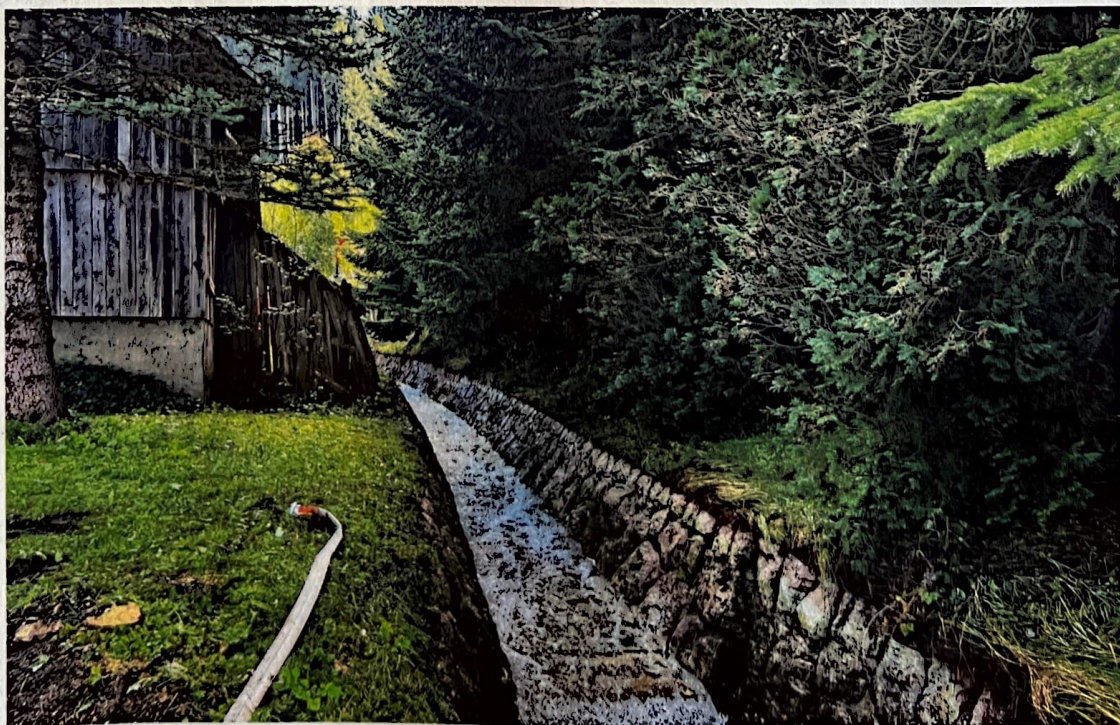
Der Moosheimerbach wurde von Bewuchs befreit und somit die Gefahr von Verklausungen gebannt. © Natalie Prügler
